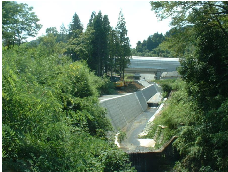
涸渇した河川の代替水源は・・・？ 笛吹市 天川の恒久対策工事 一級河川が『一級三面コンクリート張水路』に
